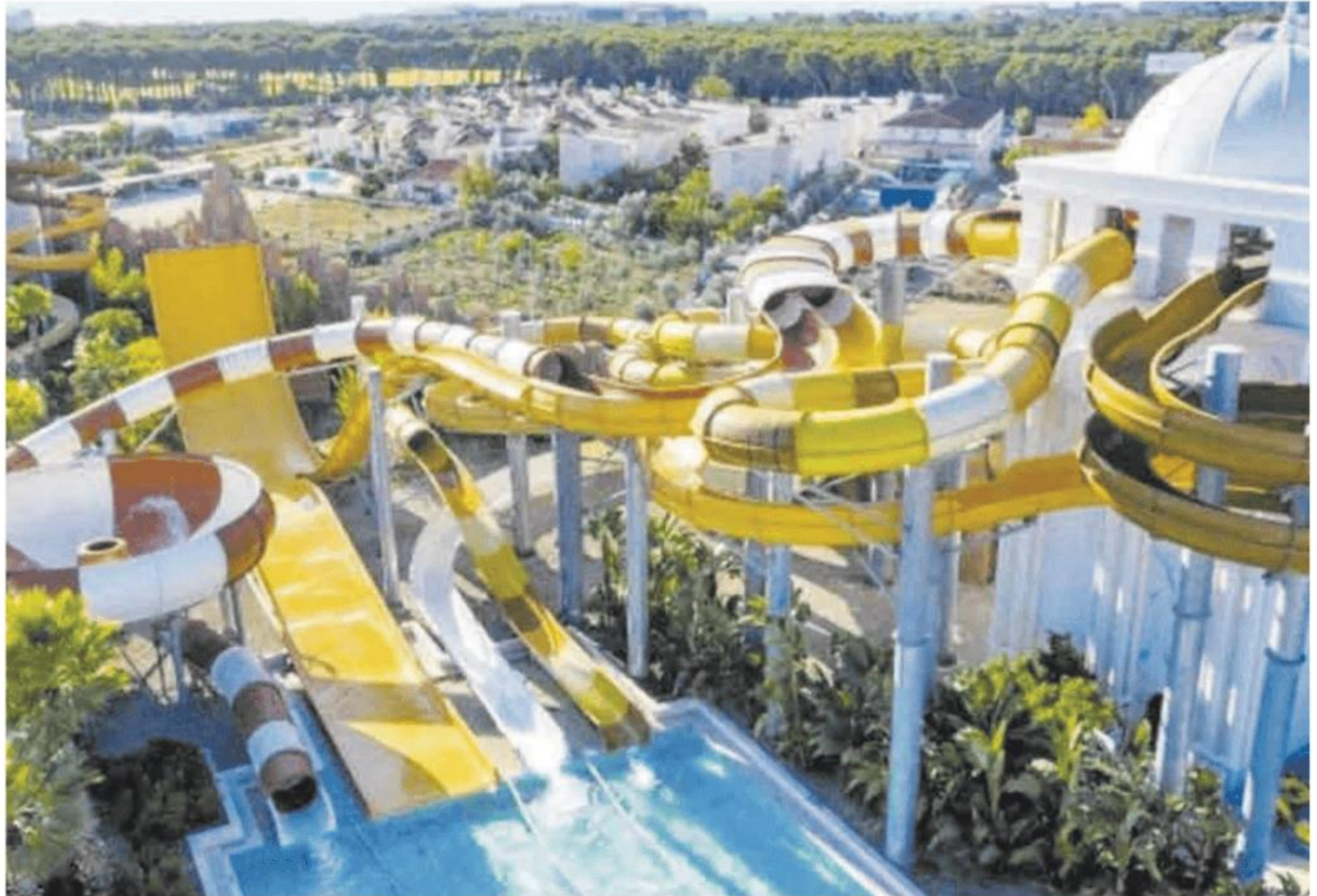
Diseño del parque acuático turco 'Land of Legends', en el que se basará la futura macro infraestructura de Casar de Cáceres.
