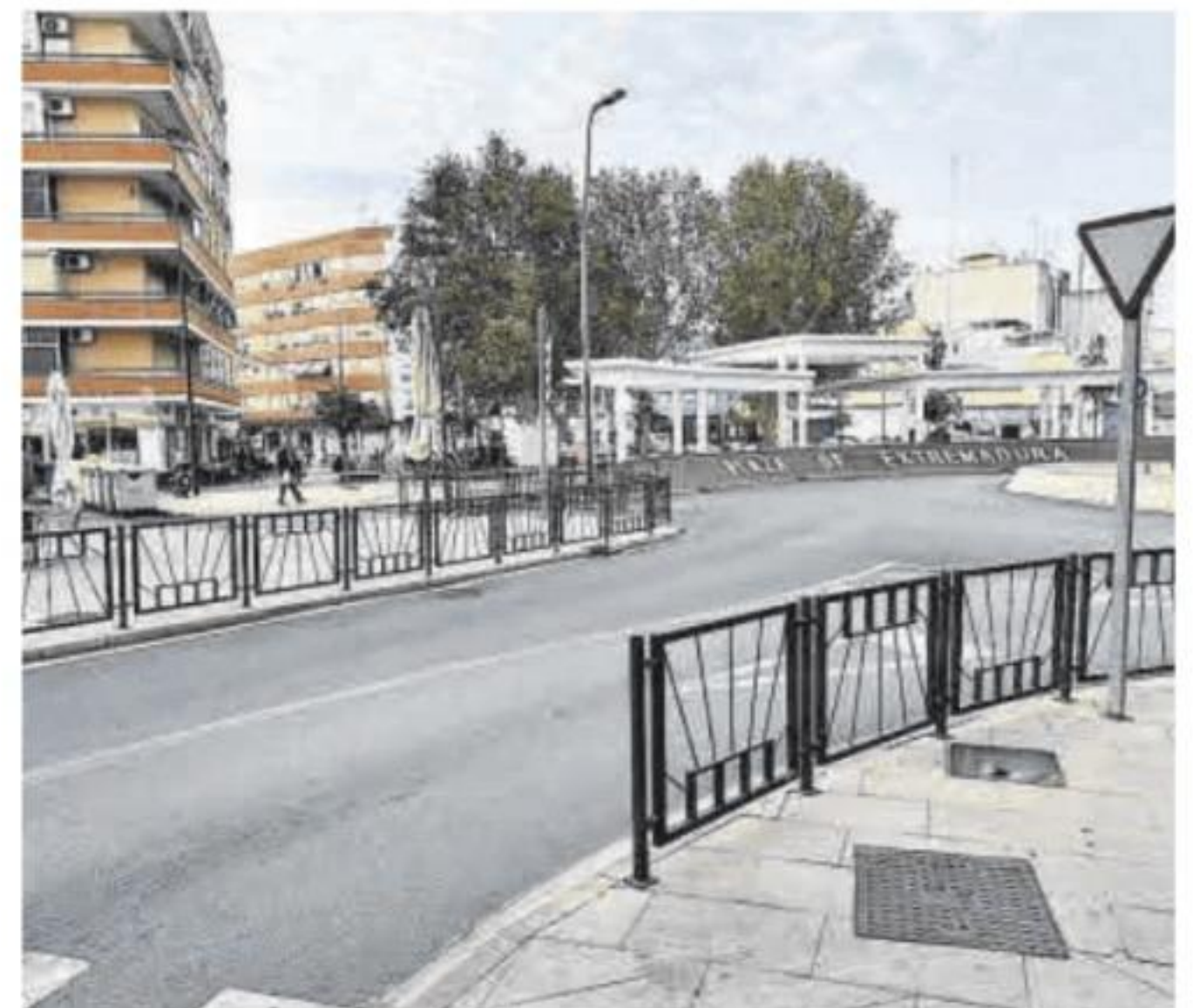
Zona de la rotonda donde tienen problemas para girar los autobuses.
